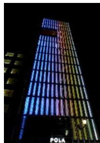
ポーラ銀座ビル ファサード (LED点灯時)
